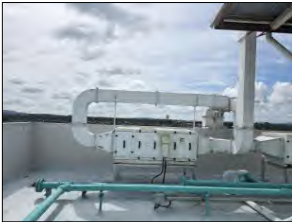
รูปที่ 3 ระบบการกรองอากาศ (Air Filter)
