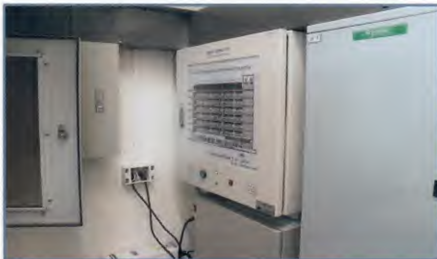
( ตู้ควบคุมระบบดับเพลิงอัตโนมัติ(อาคาร2) )
