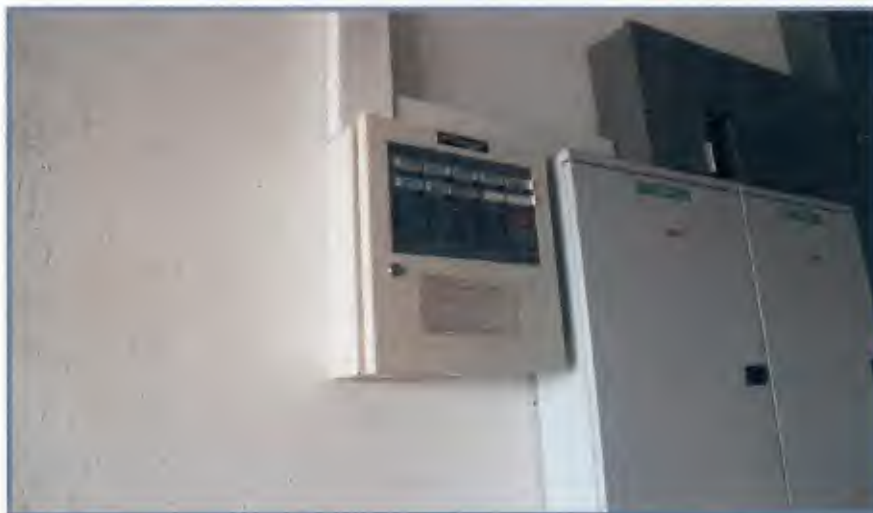
( ตู้ควบคุมระบบดับเพลิงอัตโนมัติ(อาคาร1) )
