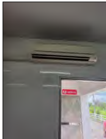
รูปที่ 24 ติดตั้งเครื่องปรับอากาศภายใน ห้องพักมูลฝอยติดเชื้อ
